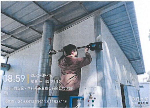
DA002 危废间有机废气排放口
